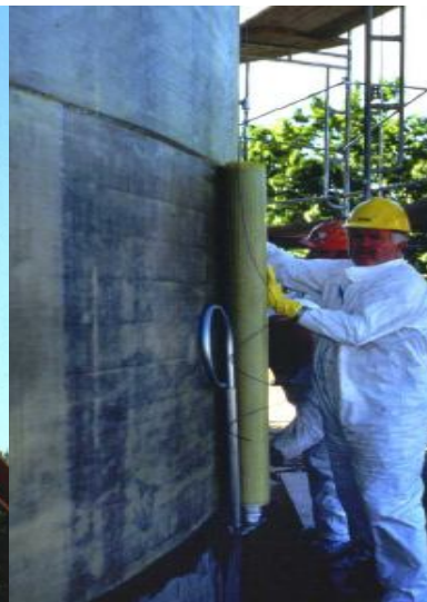
نمایی از رینگ بتنی برای مقاوم‌سازی
