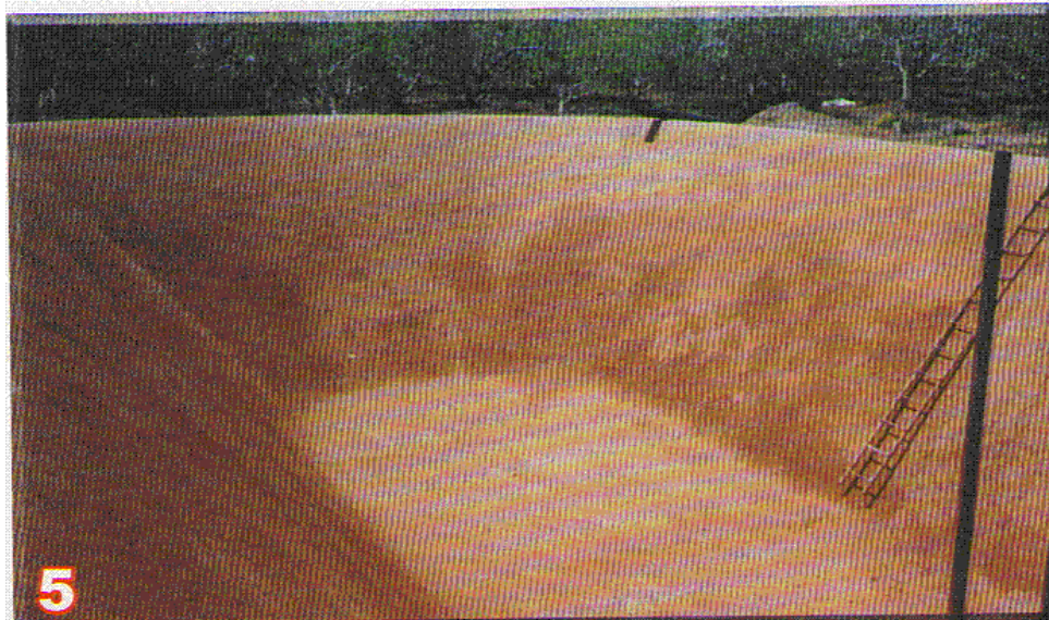
مفر ترانشه جهت مهار کردن ورق در محیط استخر
