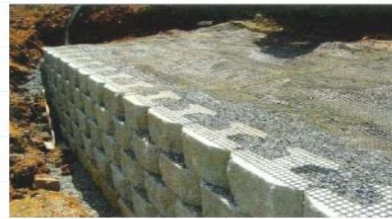
(در حین احداث)
