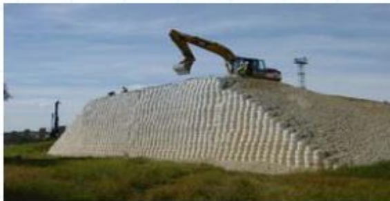
استفاده از ژئوسلها در ساخت دیواره ها و شیبها
