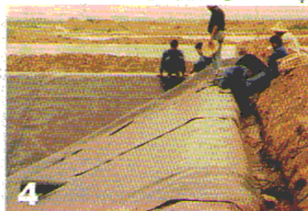
مهارد ورق در ترانشه مفر شده
