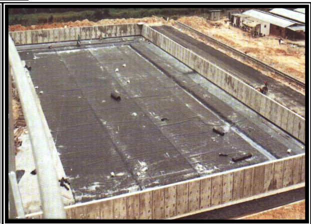
Secondary Containment پوشش ثانویه مخازن
