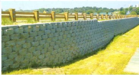
(پس از احداث) شبكة های ژئوگرید به همراه پوشش خارجی بتنی متصل به آنها و ساخت دیواره هایی با شیب قائم
