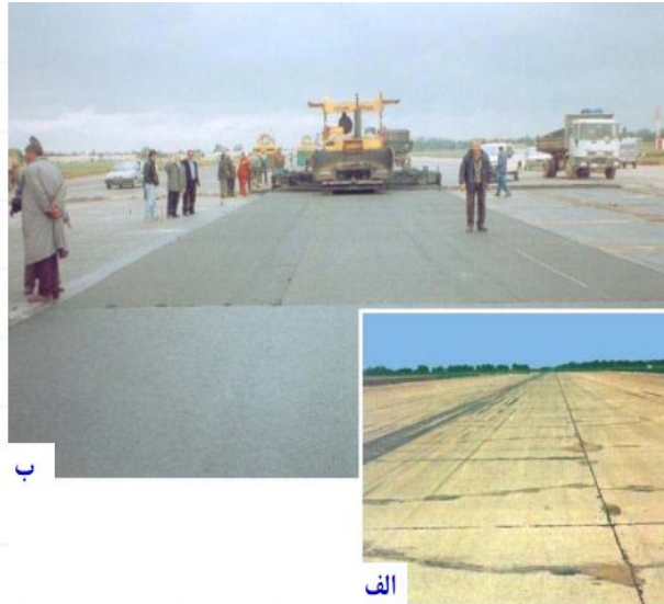
الف- باند فرودگاه کارتاز در کشور تونس تا پیش از سال ۱۹۹۲ میلادی (ترک خوردگیهای زیادی در سطح آسفالت باند فرودگاه دیده میشود) ب- روکش کردن لایه جدید آسفالت به کمک ژئوگریدها موجب افزایش مقاومت آسفالت در مقابل ترک خوردگی شده است.
