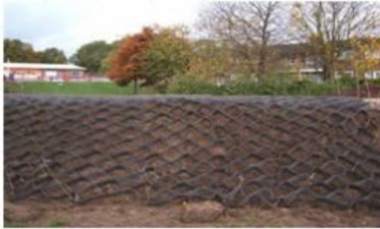
استفاده از ژئوسلها در تثبیت خاک شیبها
