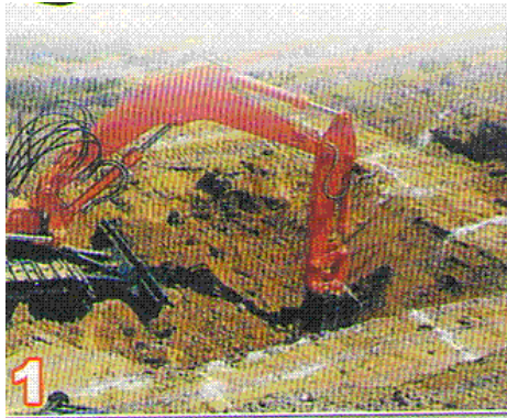
گود برداری بعد از تراز کردن سطح و گف استخر
