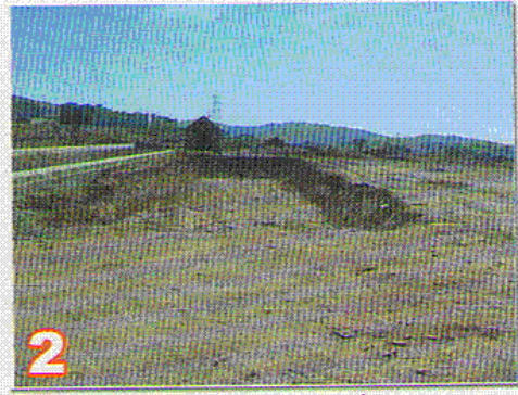
بستر گود برداری شده قبل از دادن تراکم به دیواره ها و کف
