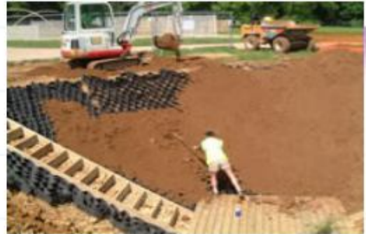
استفاده از ژئوسلها در تثبیت خاک شیبها
