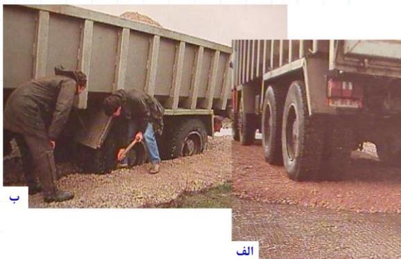
تأثیر بکارگیری ژئوگریدها در جلوگیری از نشست جاده (الف- جاده مسلح شده با ژئوگریدها -ب- جاده مسلح نشده)
