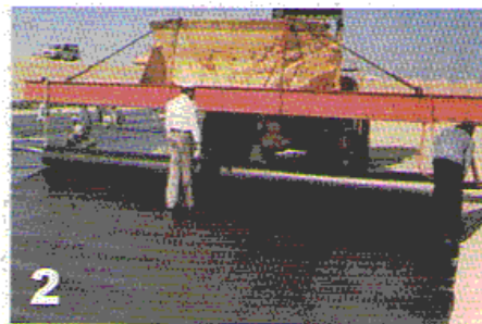
پهن کردن ورق ژئوممبران بصورت دستی و ماشینی
